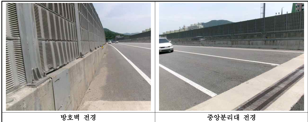
【사진 1.3.23】 방호벽 및 중앙분리대 전경
