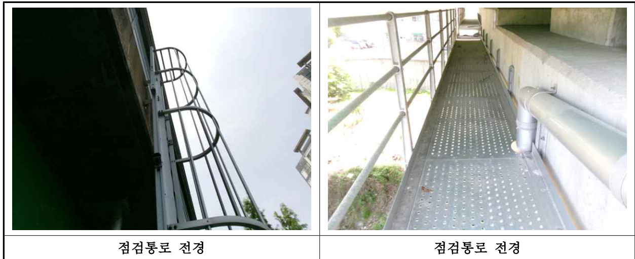
【사진 1.3.25】 교량 점검시설 전경
