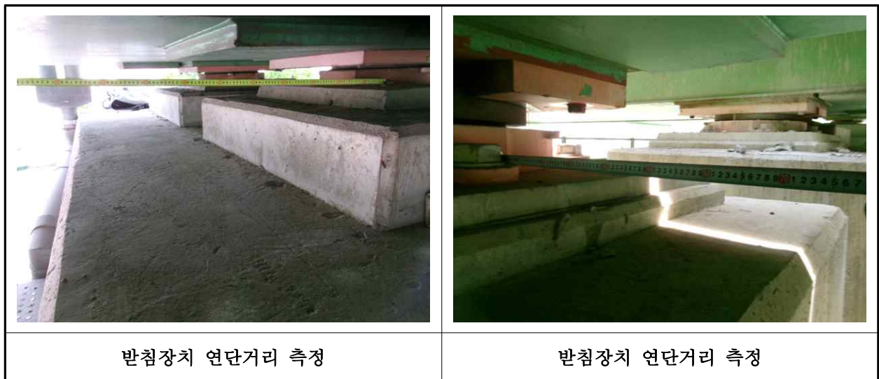
【사진 1.3.14】 교량받침장치 연단거리측정
