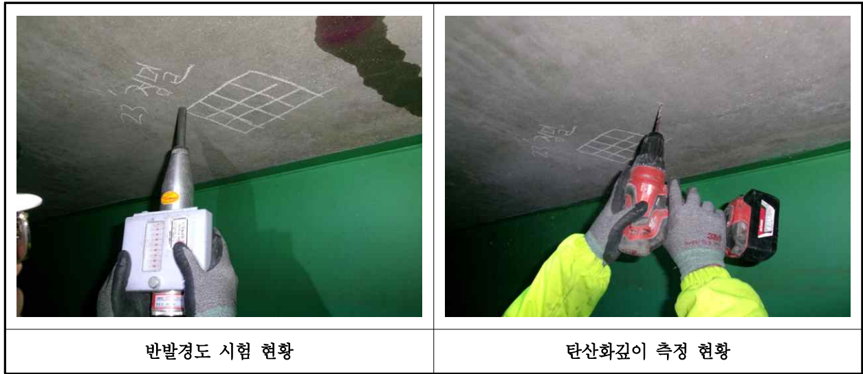
【사진 1.4.1】 콘크리트 내구성조사 현황
