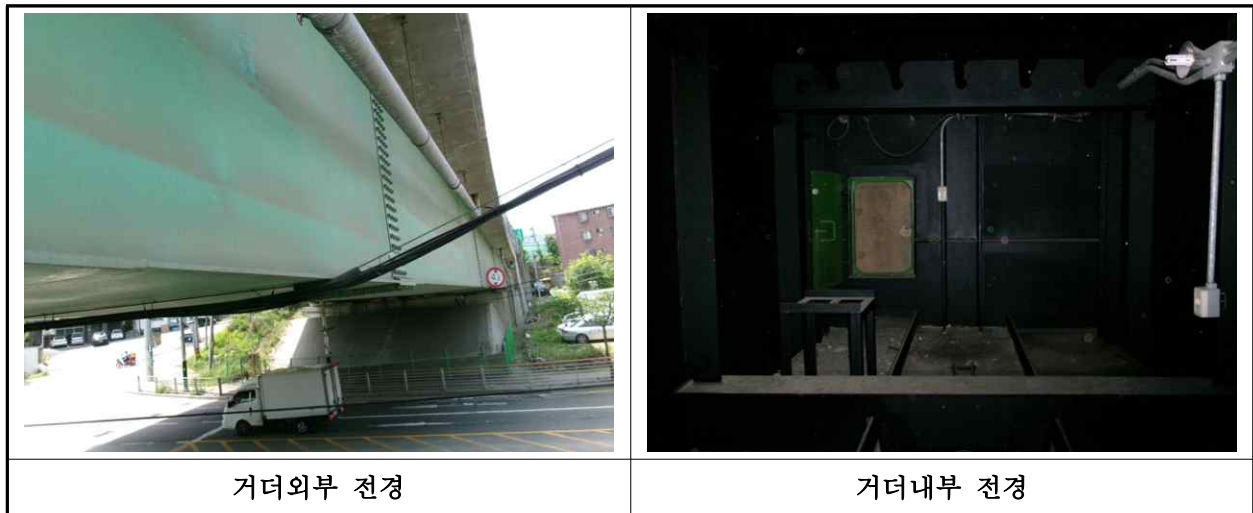
【사진 1.3.4】 거더 전경
