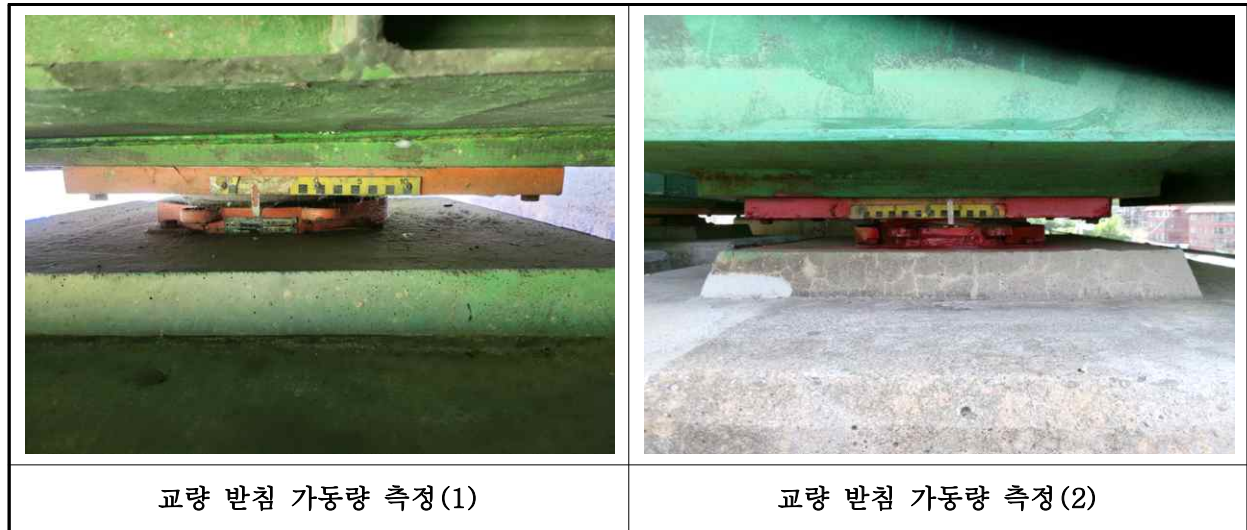
【사진 1.3.15】 교량받침 이동량 측정
