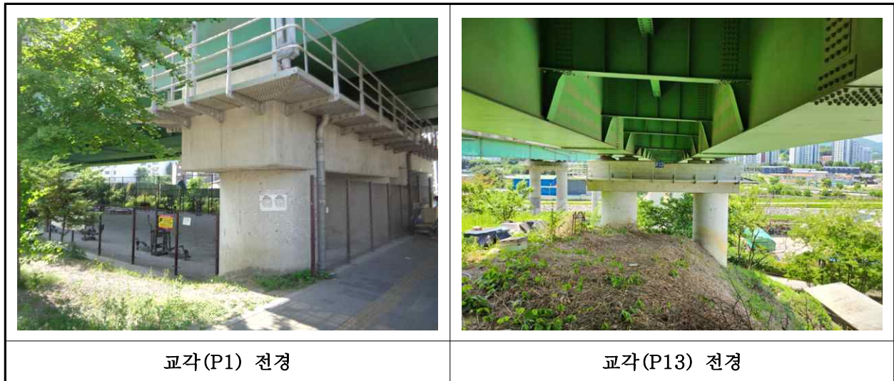
【사진 1.3.10】 교각 전경
