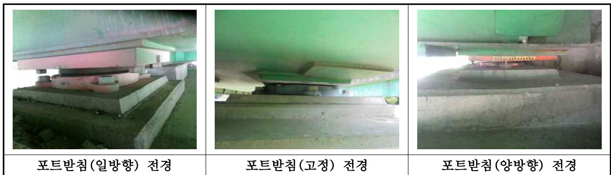
【사진 1.3.12】 교량받침 전경
