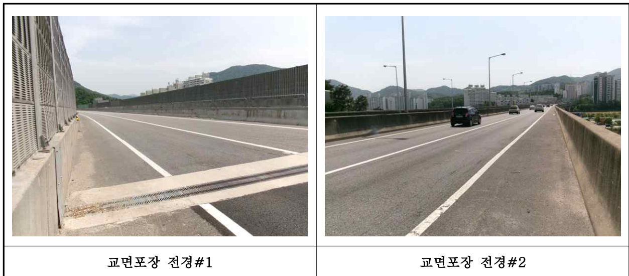
【사진 1.3.19】 교면포장 전경
