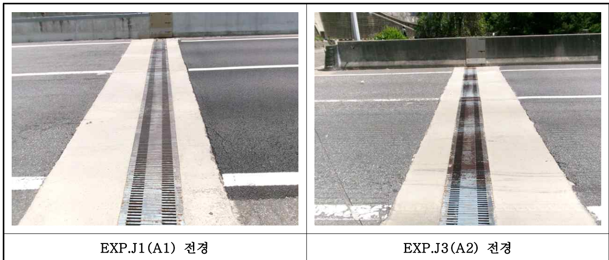
【사진 1.3.16】 신축이음장치 전경
