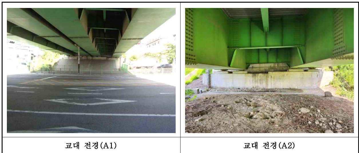
【사진 1.3.8】 교대 전경
