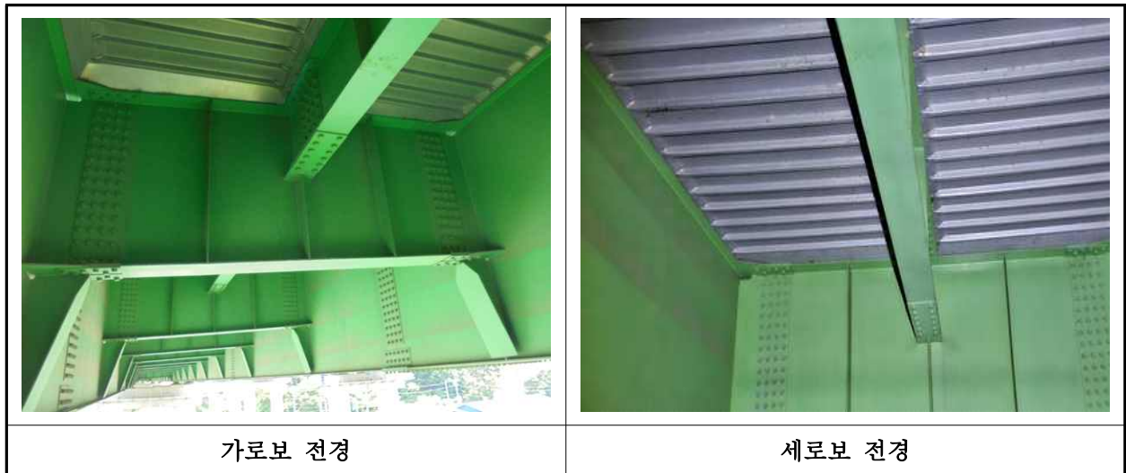
【사진 1.3.6】 가로보 및 세로보 전경
